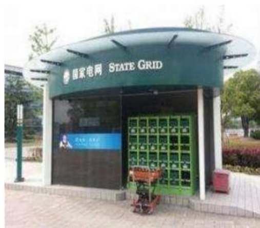
图 5-8 国网路边微型换电站
